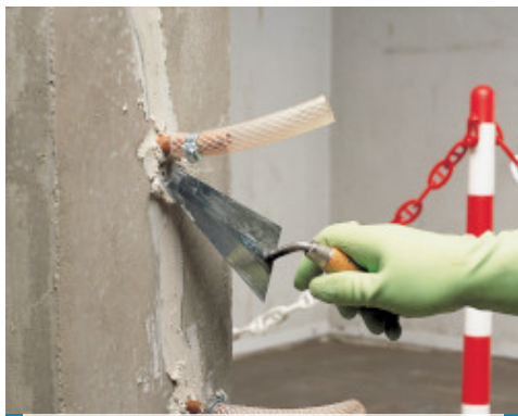
Fiksiranje injekcijskih cevčica i i zapunjavanje pukotine radi konstrukcijskog ojačanja.
