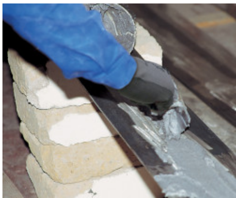
Nanošenje lepka Adesilex PG1 na čeličnu ploču
