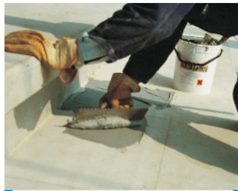
Nanošenje Adesilex PG1 nazubljenom gletericom na konstrukciju radi lepljenja prefabrikovanih gazišta
