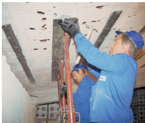
Postavljanje čelične ploče radi ojačanja konstrukcije
