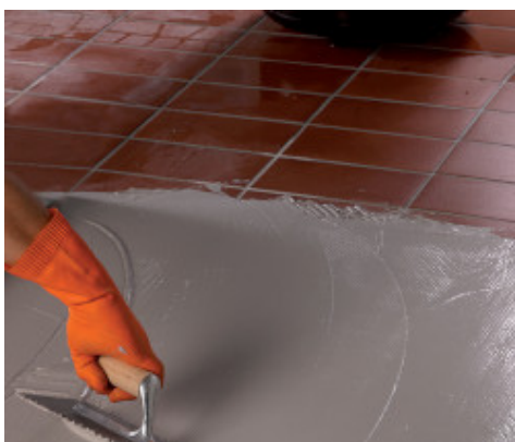
Nanošenje drugog sloja proizvoda Monolastic na mrežicu Mapenet 150.
