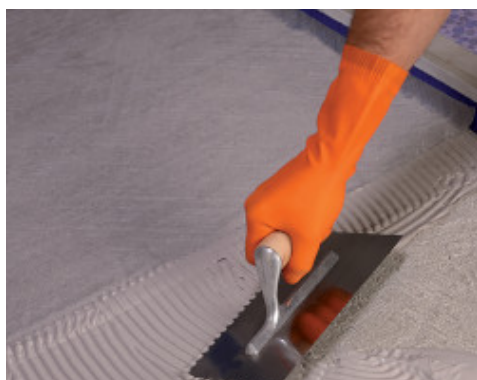
Nanošenje prvog sloja proizvoda Monolastic ojačanog filcom Mapetex Sel N preko novoizvedenog estriha.
