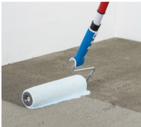
Nanošenje prajmera na podlogu
