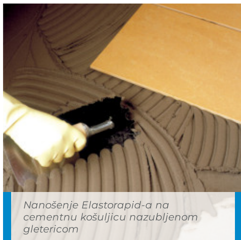
Polaganje porcelanskih pločica na košuljicu hidroizolovanu Mapelasticom
